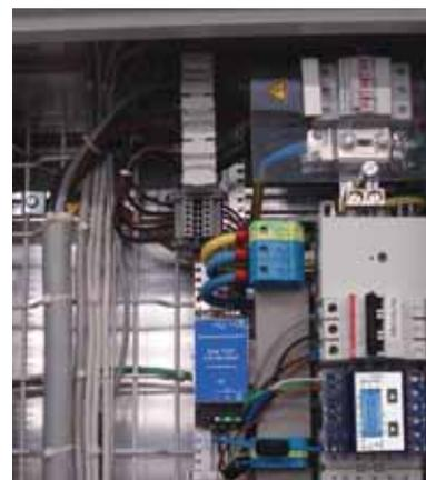
▲ Trasformatori di corrente installati direttamente nella canaletta dei cavi
